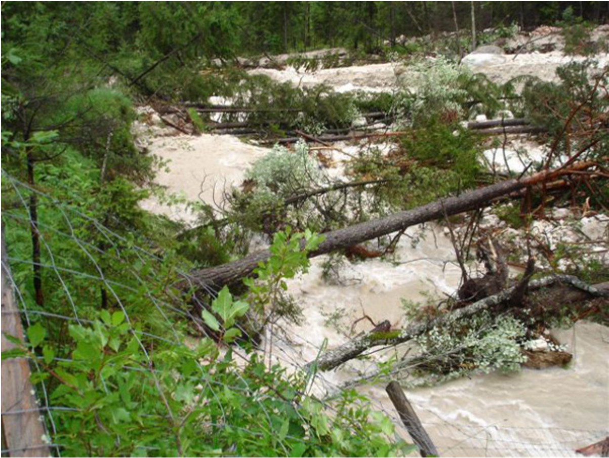
Bild: Böschungsanrisse am Klausbach beim sog. „Bienenzaun“
